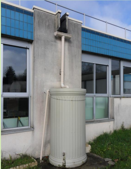
L'un des deux récupérateurs d'eau de pluie
