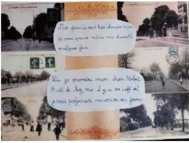
Page 5 : voici différentes photographies d'époque de l'avenue de Paris où Noël habitait.
