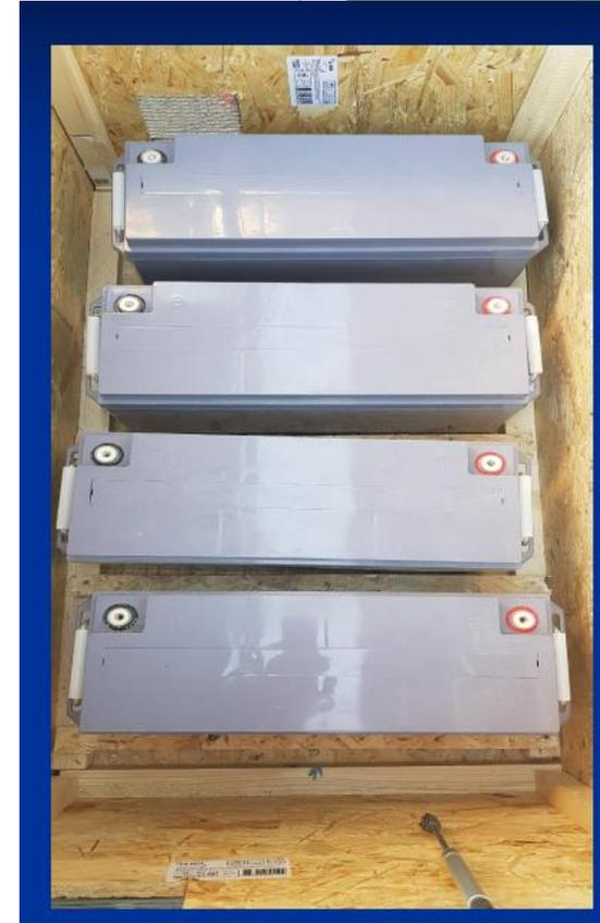
*Montage de 2 batteries en série puis mise en parallèle avec deux autres batteries en série.*
